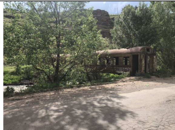
Treinwagon als brug over de rivier.
